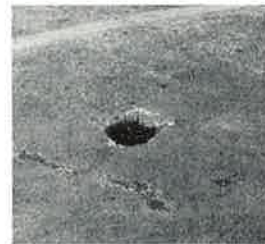
Spalling
